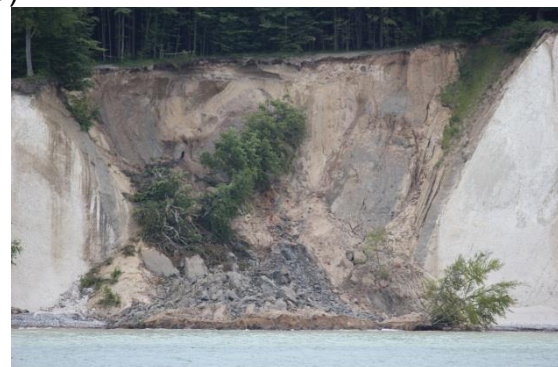
Gefahren- hier ein Abrutsch der Steilküste
